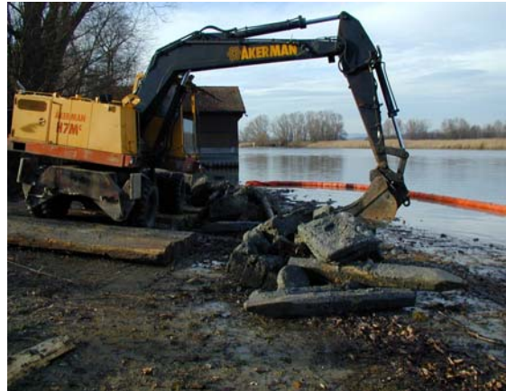
Abb.2: Arbeiten am Ufer des Untersees bei Tägerwilen. Foto: AfU TG
