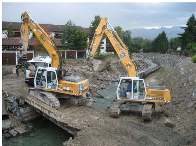
Abb.3: Umbau eines Baches innerhalb einer Siedlung. Foto: AfU TG
