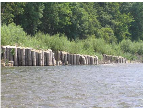
Abb.7: Holzpfahlbühnen mit Spreitlagen von Weiden, ein Jahr nach Bau. Foto: Stocker
