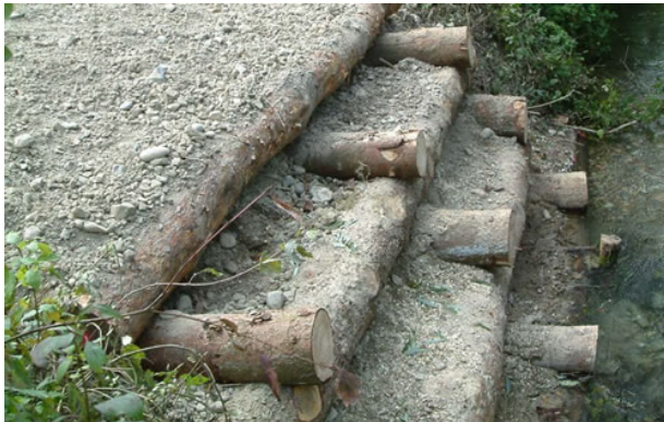
Abb.9: Einbau von Baustämmen zur Uferstabilisierung.
