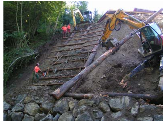
Abb.10: Sicherung eines steilen Hanges mit Baustämmen.
