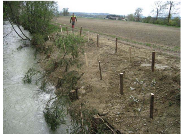
Abb.1: Rauhbaumverbau, Binnenkanal Uesslingen. Foto: AfU TG
