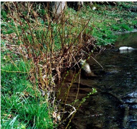
Abb.6: Uferfaschinen werden vorzugsweise zum Uferschutz in Gewässern eingesetzt, welche den Faschinen während der Vegetationszeit mindestens drei Monate Wasserfreiheit erlauben. Sie werden aus möglichst langen Weidenästen geflochten und eng zusammengebunden. Der Einbau erfolgt in flachen Mulden entlang der Mittelwasserlinie. Darin werden die Faschinen verflocht und hinterfüllt. Quelle Bilder: http://www.ingenieurbioogie.ch
