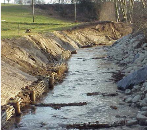
Abb.4: Uferschutz mit Faschinen und Böschungssicherung durch Jutenetze (links) und Blocksteinwurf (rechts). Flechtwerkbühnen im Bachbett zur Verlagerung des Stromstriches.
