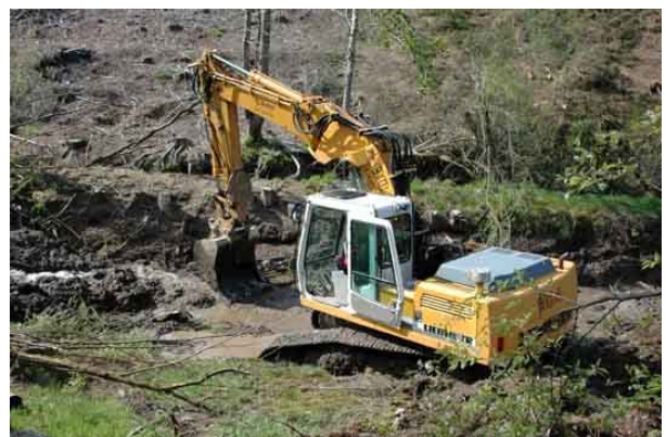
Abb.1: Wasserbauliche Arbeiten an einem Bach.
