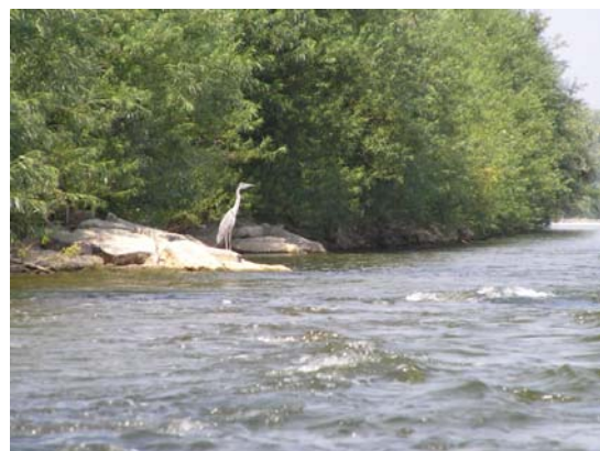
Abb.8: Kurze Steinbühnen umpflanzt mit Weidenstecklingen, einige Jahre nach Bau. Foto: Stocker
