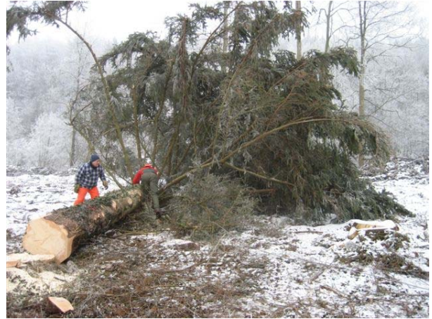
Abb.2: Vorbereitung einer riesigen Tanne zur Ufersicherung an der Sitter bei Hauptwil-Gottshaus. Foto: AfU TG
