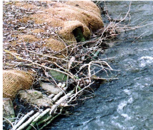
Abb.5: Uferschutz durch Faschinen und Längsholz mit Fischnischen sowie Erosionsschutz der Böschung durch bepflanzt Kokosnetz.
