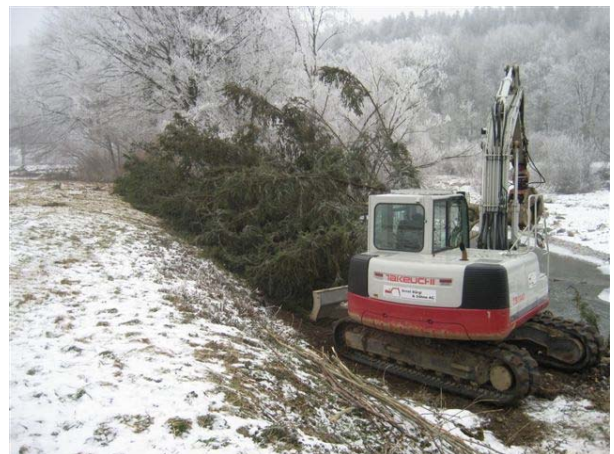
Abb.3: Einbau der Tanne ins Ufer der Sitter. Foto: AfU TG
